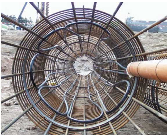
Abb. 4: Bewehrungskorb mit Absorberleitungen eines „Energiepfahles“
