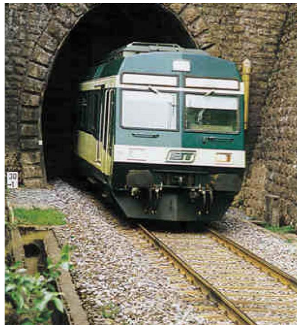
Abb. 9: Nutzung von Tunnelwässern: In einer Rigole (im Bild links unten zu erkennen) wird am Portal des Rickentunnels in Kaltbrunn das Drainagewasser zur Beheizung einer Mehrzweckhalle, einer Turnhalle, einer Zivilschutzanlage und eines Kindergartens abgeführt (Quelle: Bild NOK, Nordostschweizerische Kraftwerke).
