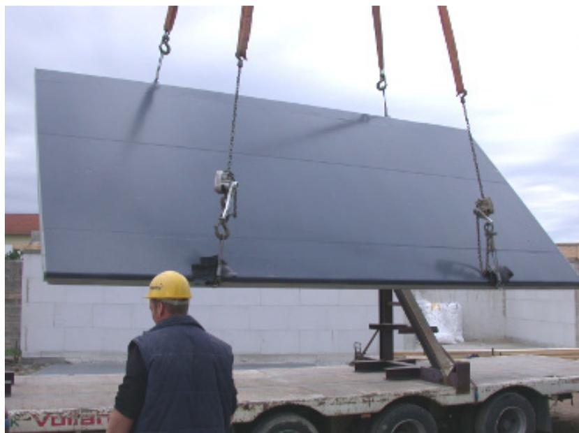
*Bild 4: iRoof-Oberschale auf druckfester Dämmung mit Hangabtriebssicherung, BVH Oberhausen-Rheinhausen*
