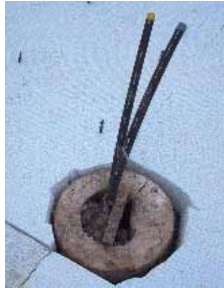
Abb. 3: Fertiger Energiepfahl mit eingebauter Sonde
