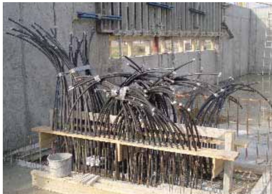
Abb. 4: Sammelregister aller Leitungen
