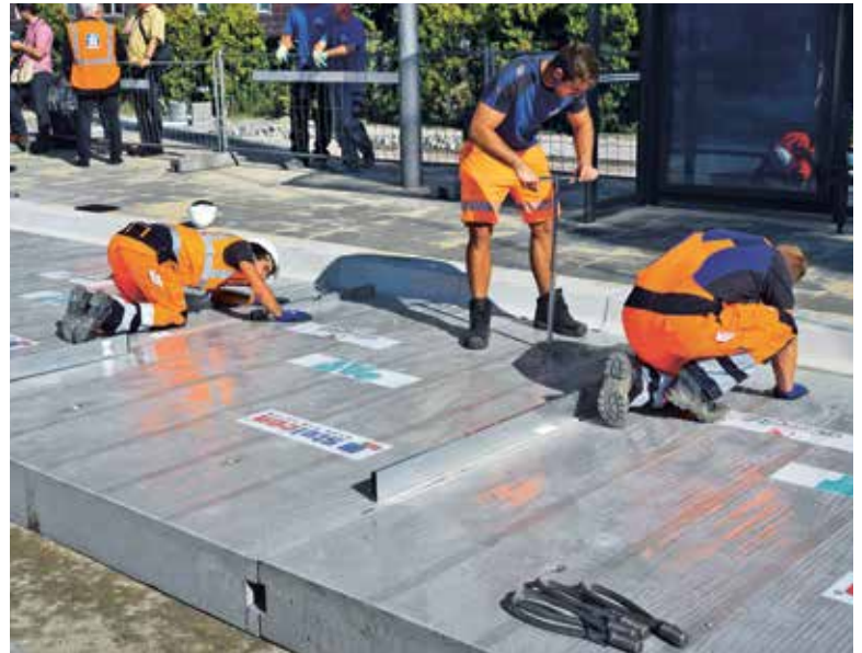
Ausrichtung und Höhenjustierung der Fertigteile
