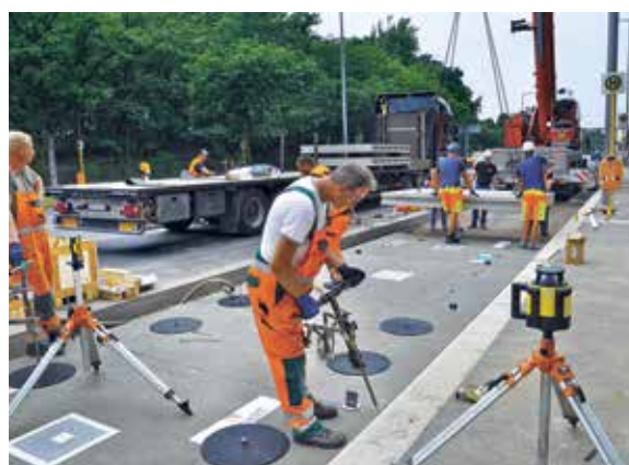
Parallel laufende Arbeiten an einer Fertigteilbaustelle
