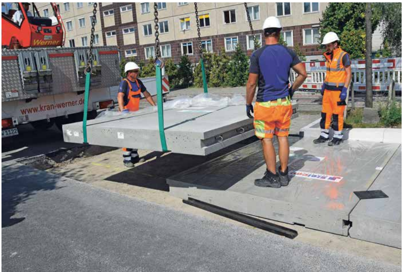
Alternative Verlegetechnik mittels Hochleistungsgurtbändern
