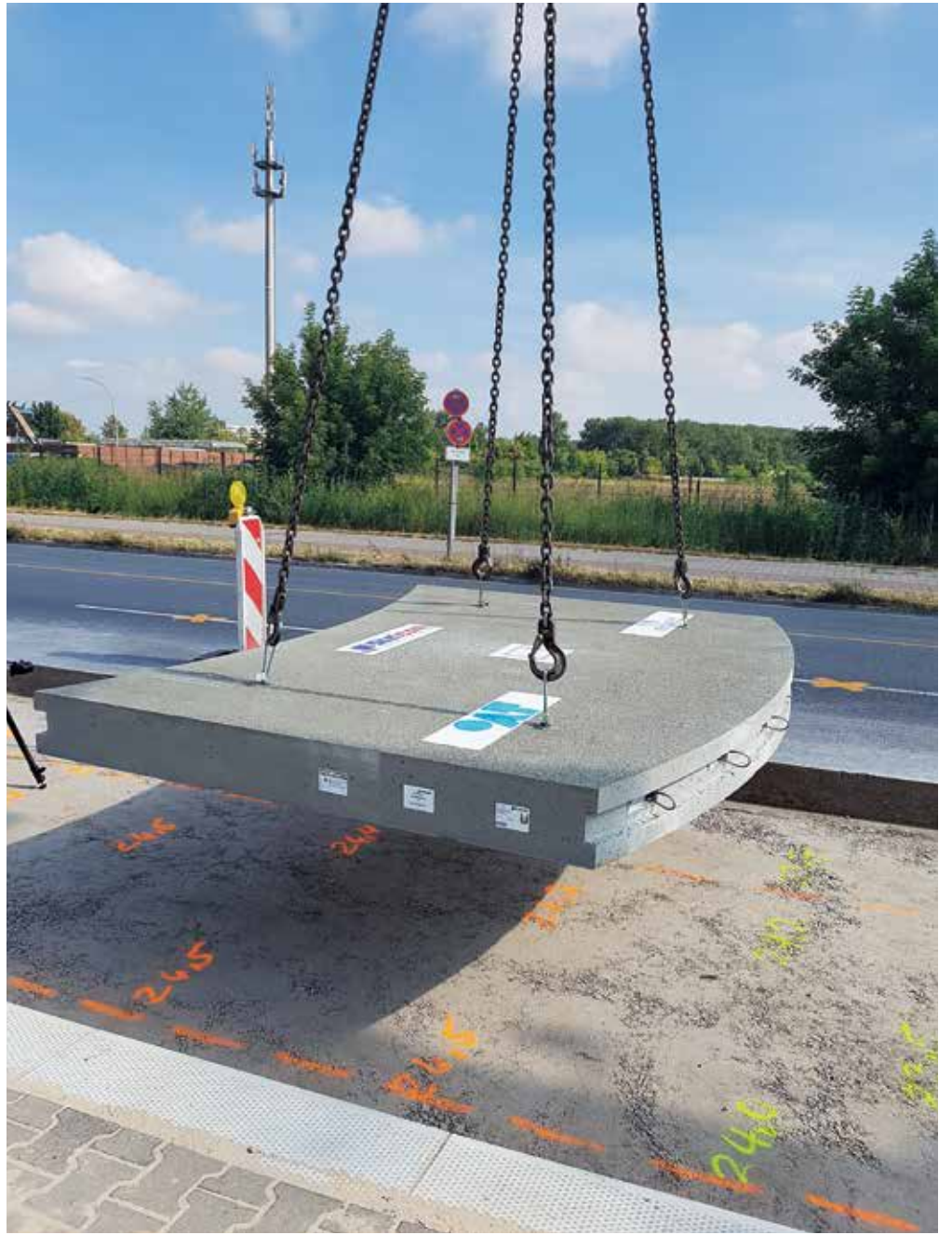
Fertigteil mit gekrümmten Querfugen
