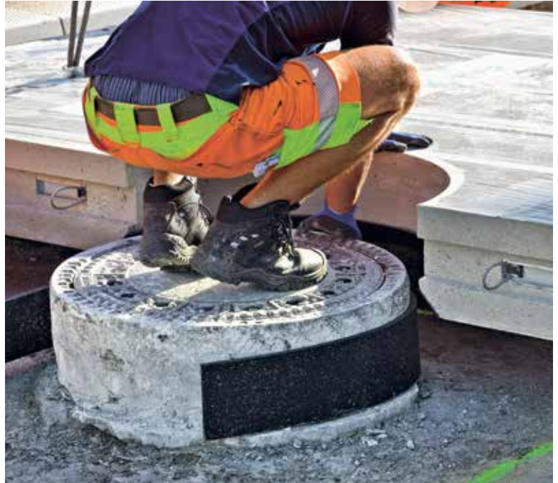
Verlegung des ersten Fertigteils am Schacht
