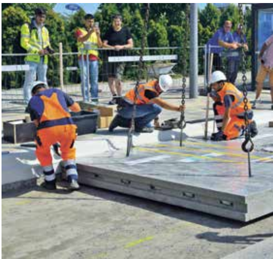
Verlegung der zweiten Fertigteilplatte am Schacht mithilfe des klassischen Verlegesystems (Stahlseile und Schwerlastanker)
