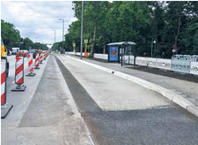
Fertiggestellte Bushaltestelle mit Fertigteilen
