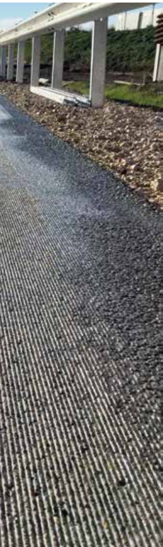
Ausführung der Grindingstruktur auf der A5. Oben links: Trägerwelle mit Diamantscheiben.
