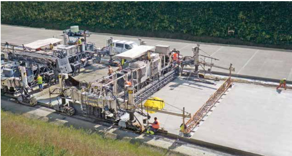
Einbau der Betondecke.
