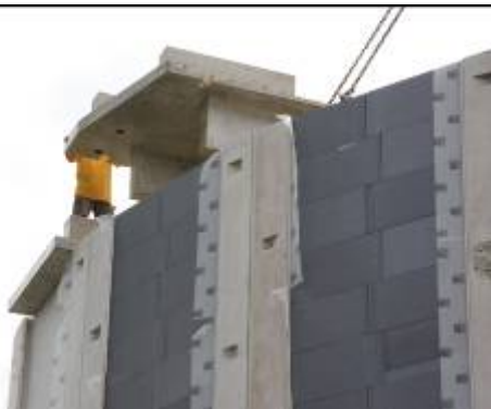
Bild 4: Nach der Außenwand-Dämmung folgt das Einhängen der Deckenelemente
