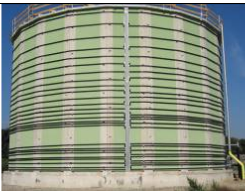
Bild 5: Nach dem Anbringen der Spannseile ist der MABA-Tank fertig für die Druckprüfung
