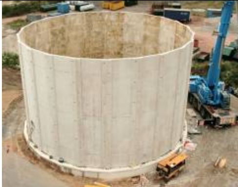
Bild 3: Nach rund 22 Arbeitsstunden ist die Behälterwand fertig
