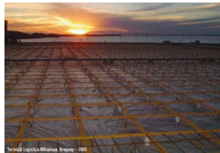
Abb.1: Vorgespannte Bodenplatte direkt auf Untergrund bzw. auf Gleitschichte (Fotos: SUNCOAST; VSL)
