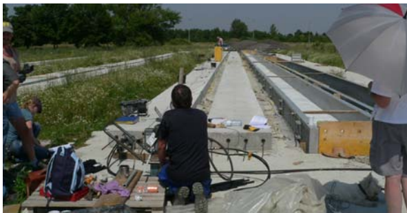
Abb.2: Vorspannen Platte 5 und 6
