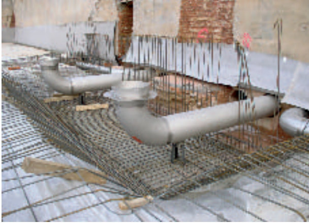
Bild 3: Vertiefung im Bereich der Entnahmeleitungen
