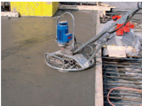
Bild 5: Zur Verringerung der Wassereindringtiefe und Vergütung der Oberfläche der Stahlbetonsohle wurde diese flügelgeglättet. Diese Maßnahme ist mittlerweile in der MA 31 zum Standard erhoben worden.
