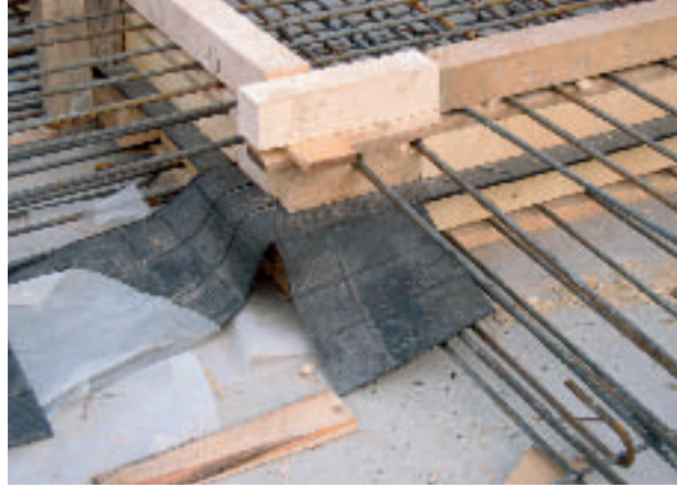
Bild 4: Arbeitsfuge Bodenplatte
