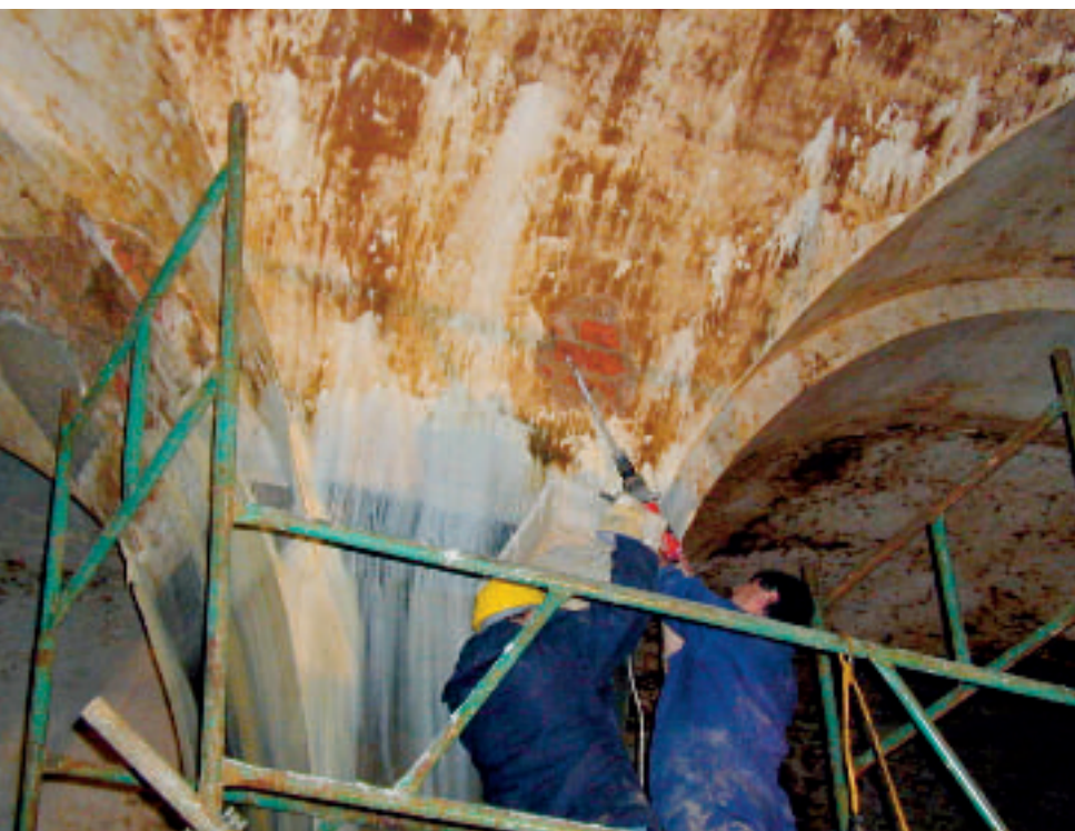
Bild 1: Schadensbild Säulenkopf
