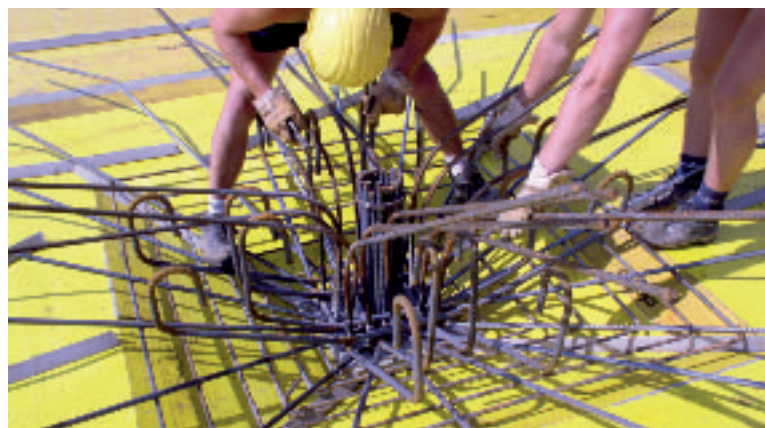
Bild 6: Schalungs- und Bewehrungsausbildung beim Säulenkopf
