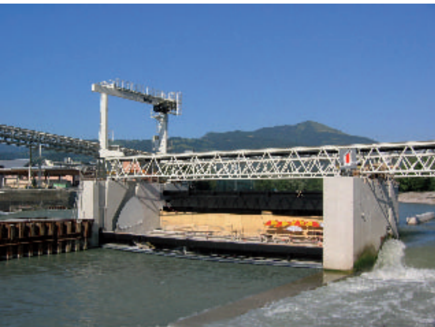
Blick vom Unterwasser auf das Wehrfeld 2 bei gesetzten Dammtafeln vor der Klappenmontage. Wesentliches Element bei der Gestaltung der Wehranlage ist der Kontrast zwischen den massiven Stahlbetonpfeilern zu den transparenten Stahlraumfachwerkträgern des Portalcranes. Die helle Stahlkonstruktion bildet den Konnex zu den mit Kollektorfachwerken verbundenen Werkshallen der Firma M-real Hallein AG. Fotos: © Christoph Peterstorfer, Salzburg AG
