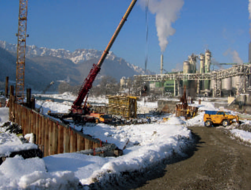
Bauzustand der Wehrbaugrube bei Herstellung des Wehrpfeiler 3 im Winter 2006. Die Wehrbaugruben müssen mit relativ niedrigen Fangedämmen umschlossen werden, um ein Überfluten der Oberwasserdämme zu verhindern. Den Anschluss an die Pfeiler bilden Kastenfangedämme. Die Untergrundbeschaffenheit und die zahlreichen Holzpfähle ließen ein Rammen der Spundbohlen ohne Vorbohren nicht zu.
