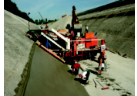
Abb. 1: Einbau des 4 m breiten, horizontalen Böschungstreifens mittels Wirtgen SP 500 und Offset-Schalung. Der gesamte Kanal wurde mit diesem untersten Streifen ausgekleidet.
