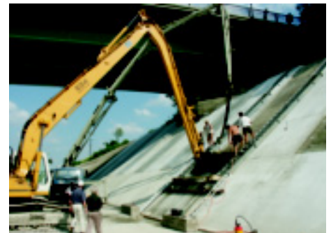
Abb. 4: Schließen der sekundären Pilgerschrittfelder mittels Baggereinbaubohle
