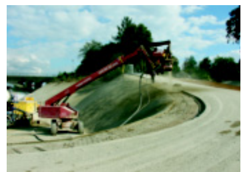
Abb. 5: Die verbleibende Rampe in das Hafenbecken Töging: Hydraulisch nicht relevante Handeinbaubereiche wurden mit bewehrtem Spritzbeton geschlossen.
