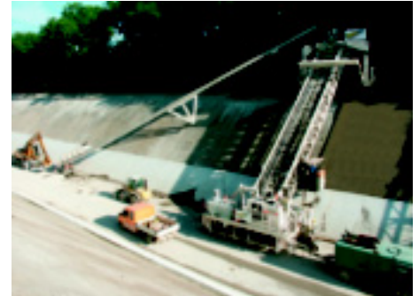
Abb. 3: Der durch ein 37 m langes, frei tragendes Rotec-Förderband versorgte Betonbrückenfertiger FCX 2 beim Einbau auf einer 14 m langen Böschung. Die 3 FCX Prototypenfertiger wurden eigens für die ARGE entwickelt und gebaut. Fotos: M. Müller
