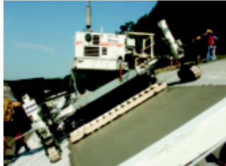
Abb. 2: Blick von der Nacharbeitsbühne: Der 25 Tonnen schwere Wirtgen SP 500 Fertiger wird von einer 60 Tonnen wiegenden Raupe gehalten.
