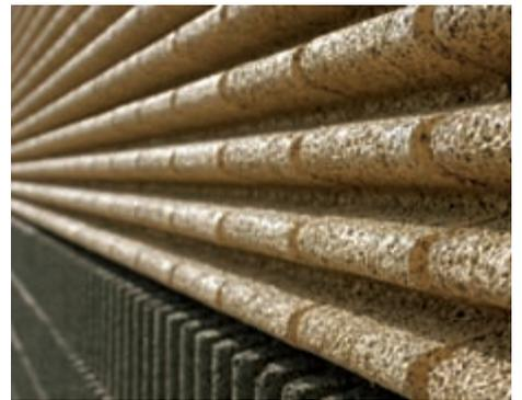
Bild 2: Lärmschutzwandelement aus Holzbeton
