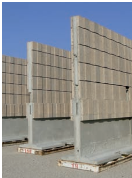
Abb. 3: Die Lärmschutzwände stehen für den Transport zur Baustelle bereit.
