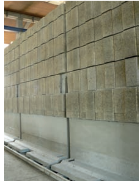
Abb. 2: Der Fuß ist für die Aufnahme der Delta Bloc® Leitwände vorbereitet.
