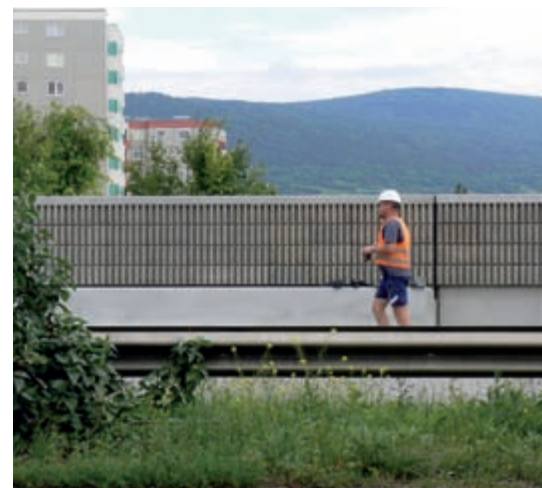
Abb. 5: Durch ihre Nähe zur Lärmquelle schützt die Lärmschutzwand von MABA FTI die Anrainer optimal.
