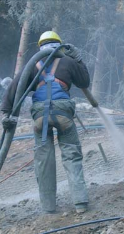
Anwendung bei der Hangsicherung
