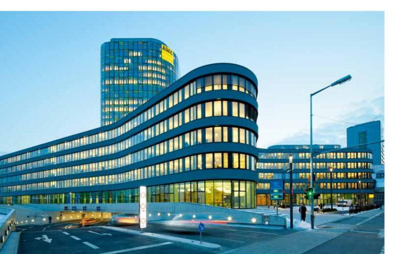
Auch in diesem Gebäude wird eine energetisch sinnvolle Gebäudekonzeption umgesetzt, von geothermischer Nutzung für Bauteilaktivierung bis hin zur doppelschichtigen Fassade, die eine natürliche Lüftung der Büros im ganzen Gebäude ermöglicht und gleichzeitig die identifizierende Farbgebung integriert, die der Fassade ein unverwechselbares Gesicht gibt.
