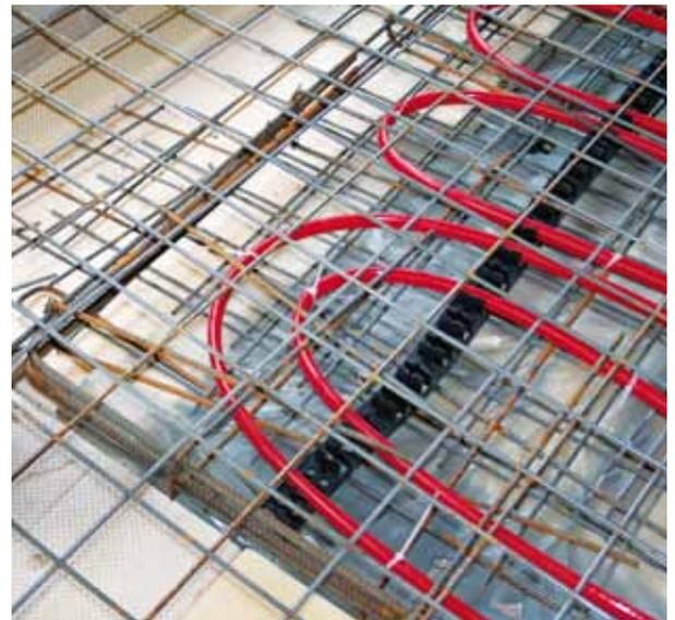
möglichst gering zu halten. Mittels dieses Wärmespeichers werden die nicht gleichmäßig über den Tag zur Verfügung stehenden Abwärmemengen gespeichert und gleichmäßig an den Raum abgegeben. Der Markt wird fast zur Gänze mit der Abwärme der Gewerbekälteanlagen beheizt. Erst bei Außentemperaturen unter minus 5° C wird unterstützend eine Luftwärmepumpe in Betrieb genommen.
