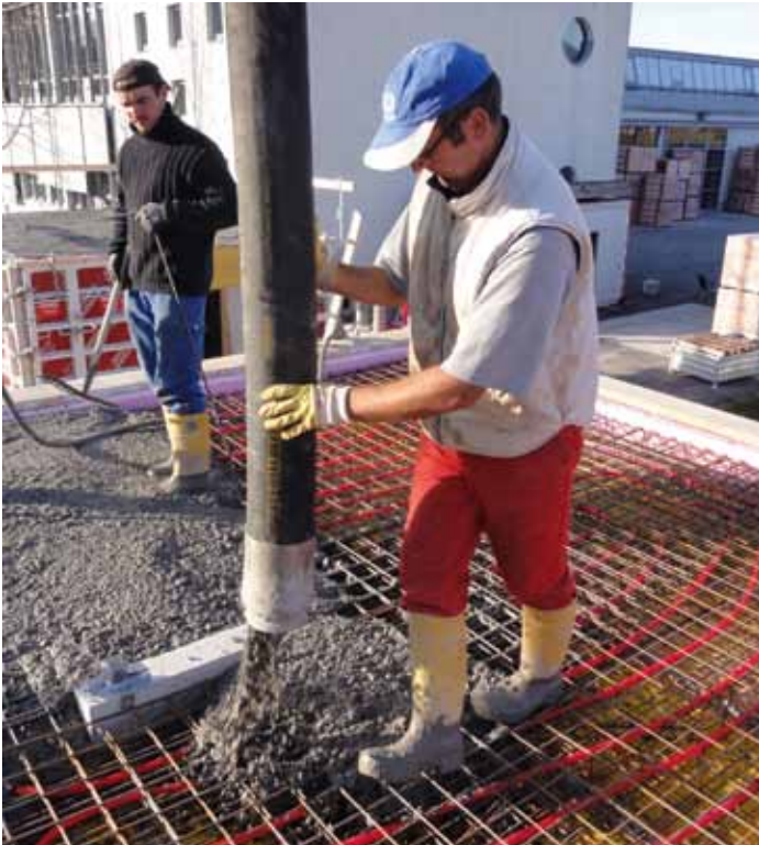
Verlegung des sauerstoffdichten Rohmaterials von Rehau und Einbetonieren der Sensorpakete
