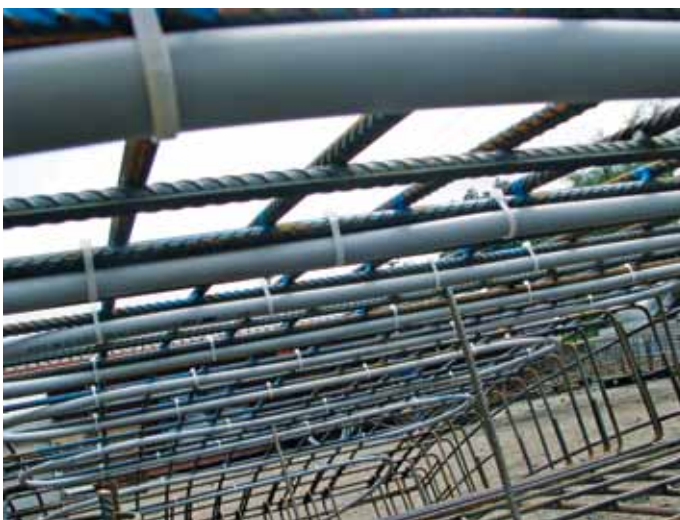
An den Bewehrungskorb angebrachte Absorberrohre
