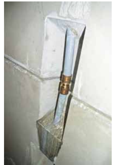
Aussparung mit REHAU Fitting zum Verbinden der Absorberrohre
