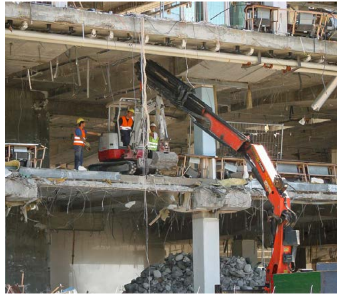
Abbruchmaterial kann wiederverwendet werden – mit Recyclingbeton auf dem Weg zum dekarbonisierten Bauen.
