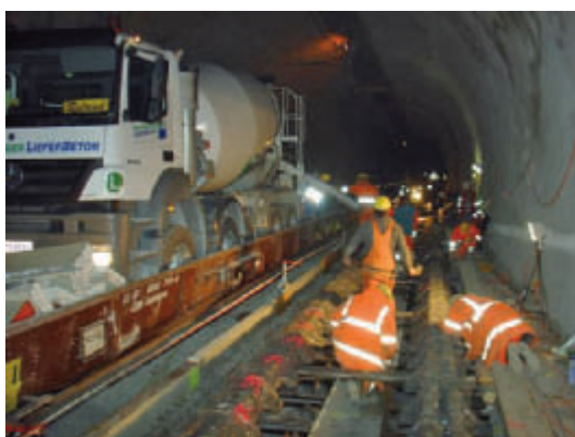
Einbausituation SCC-Beton vom Fahrnischer
