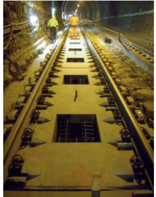
Feste Fahrbahn mit Gleisragplatten. Für den Betoneinbau vorbereitete feste Fahrbahn, gut zu sehen die rechteckigen Vergussbetonöffnungen
