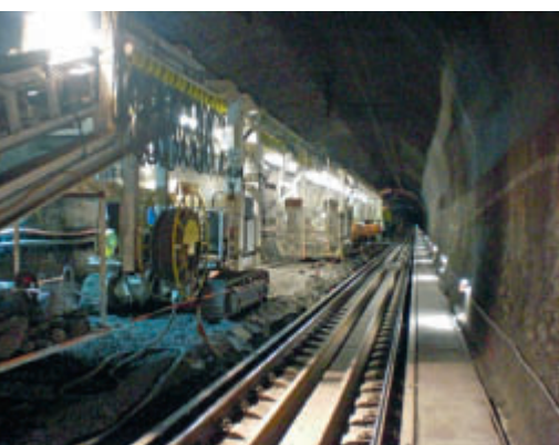
Ausbau Schottergleis unter Aufrechterhaltung eines Betriebsgleises. Im Bild ist die Gleisabtragsmaschine.
