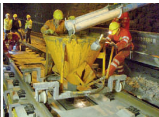
Vergussbetoneinbau im Arlbergtunnel
