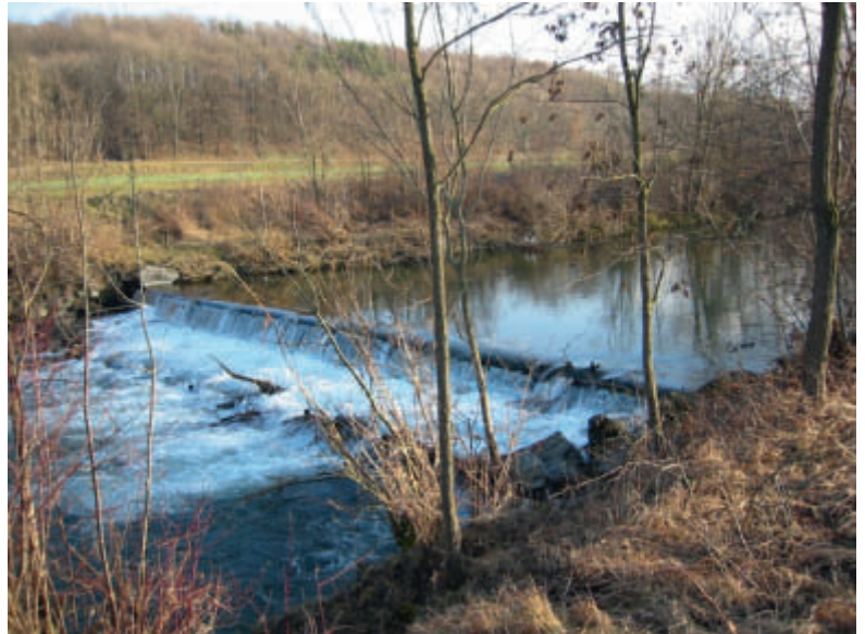
Typischer Standort für ein 40-kW-Gravitationswasserwirbelkraftwerk an einem 16 m breiten Fluss mit 5 m 3 /s mittlerer Wasserführung
