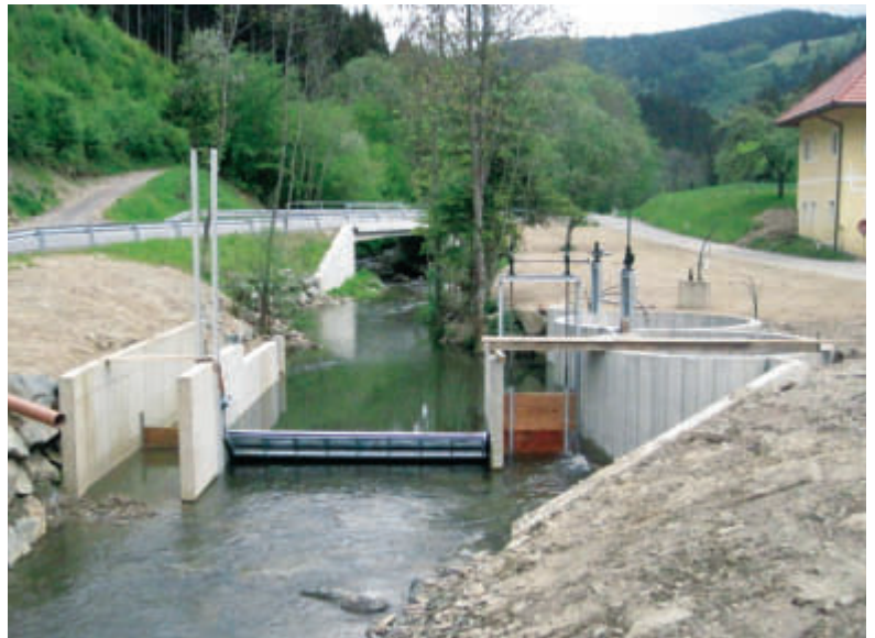
Gravitationswasserwirbelkraftwerk mit zwei Turbinen am Wimitzbach in Kärnten
