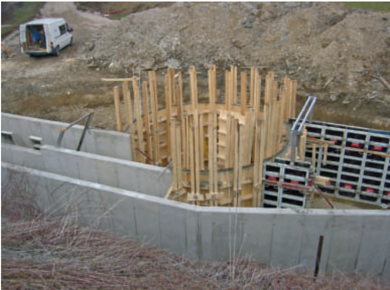
Oben und unten: Errichtung des Rotationsbeckens des Gravitationswasserwirbelkraftwerks in Obergrafendorf
