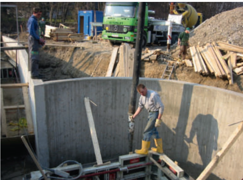
Oben und unten: Errichtung des Rotationsbeckens des Gravitationswasserwirbelkraftwerks in Obergrafendorf
