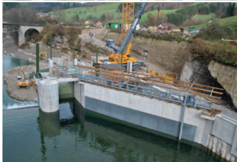
Oben: Bewehrung und Betoniervorgang Wehrrücken Unten: Einlaufbereich und Grundablass
