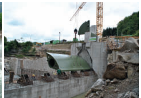
Einheben der Wehrklappe
