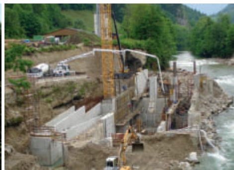
Phase 1: Wände Krafthaus und Grundablass
