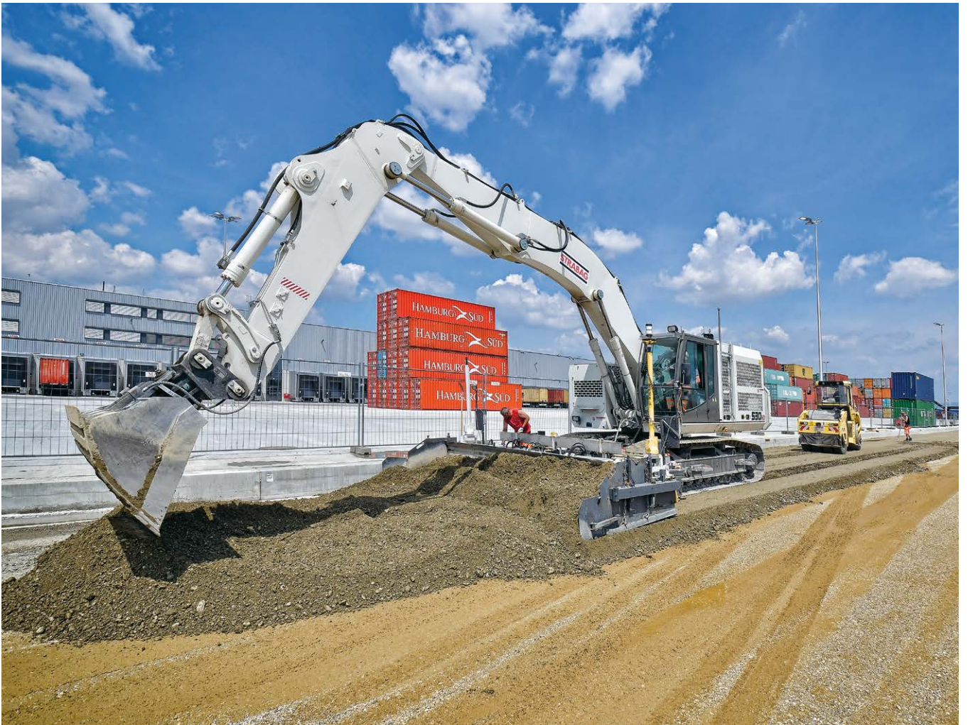
Einbau einer hydraulisch gebundenen Tragschicht
