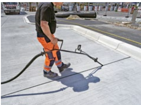
Fugenverfüllung mit Heissbitumen Typ N2
