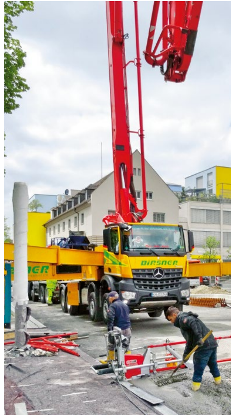
Einbringen des Betons mit Pumpe
