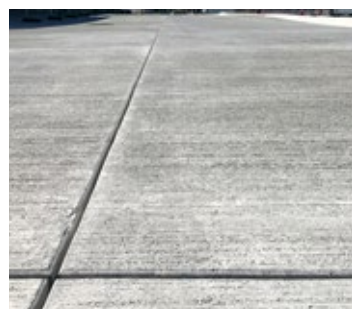
Geschnittene, noch unverfüllte Fuge
