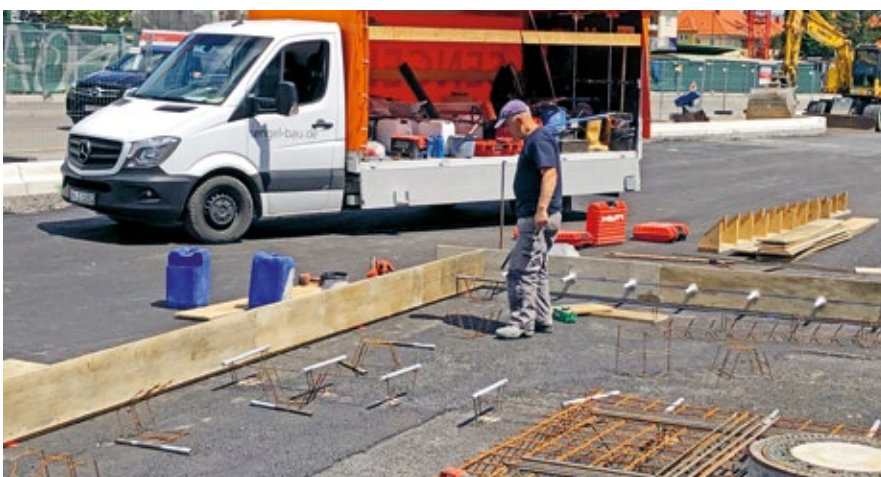
Fugen/Anker/Asphalttragschicht, Bewehrung und Raumfuge bei Einbauten
