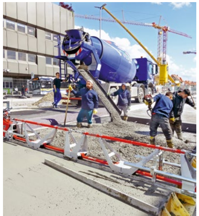
Einbringen des Betons mit Rutsche und Rüttelbohle
