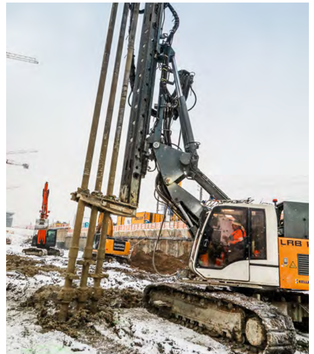
Wichtige Vorarbeiten für das innovative Energiekonzept: 64 Tiefensonden in 140 Meter Tiefe sorgen mit drei Wärmepumpen und Bauteilaktivierung für eine fossillfreie Energieversorgung.
