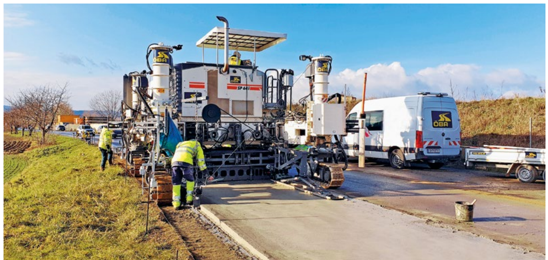
Halbseitiger White- Topping-Einbau mit Betondeckenfertiger
