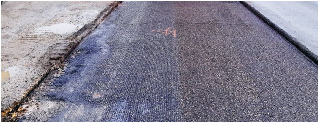
Gefräste und gereinigte Asphaltoberfläche
