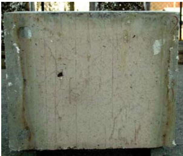
Abbildung 1-12: Oberflache von M6 (3 kg/m 3 ) nach dem Brandversuch
