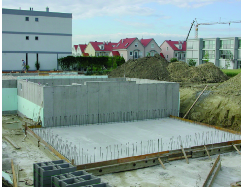
Bild 2: Rohbau der Fundamentplatte und Kellerwand
