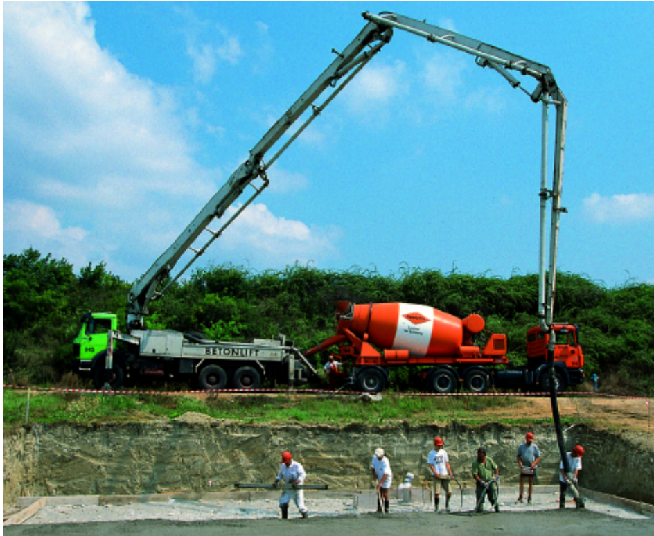
Bild 4: Einbringen von Stahlfaserbeton mittels Betonpumpe
