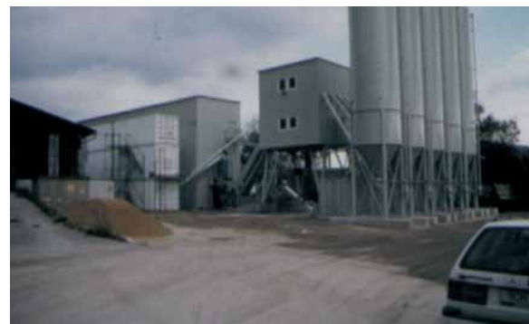
Bild 6: Misch- und Scherbeneisanlage Lainzer Tunnel
