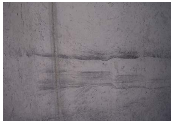
Abbildung 2: „Aufgeschwommene“ Leichtpartikel auf der Oberfläche eines Frischbetons und einer Sichtbetonwand
