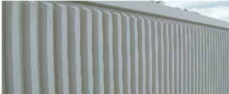
Bild 4: Lärmschutzwände 10 m lang und 3 m hoch; die Wandelemente weisen eine exakte Profilierung und hohe Oberflächenqualität auf
