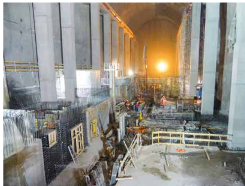
Maschinenkaverne mit fertiggestellter Kranbahn, Juni 2016
