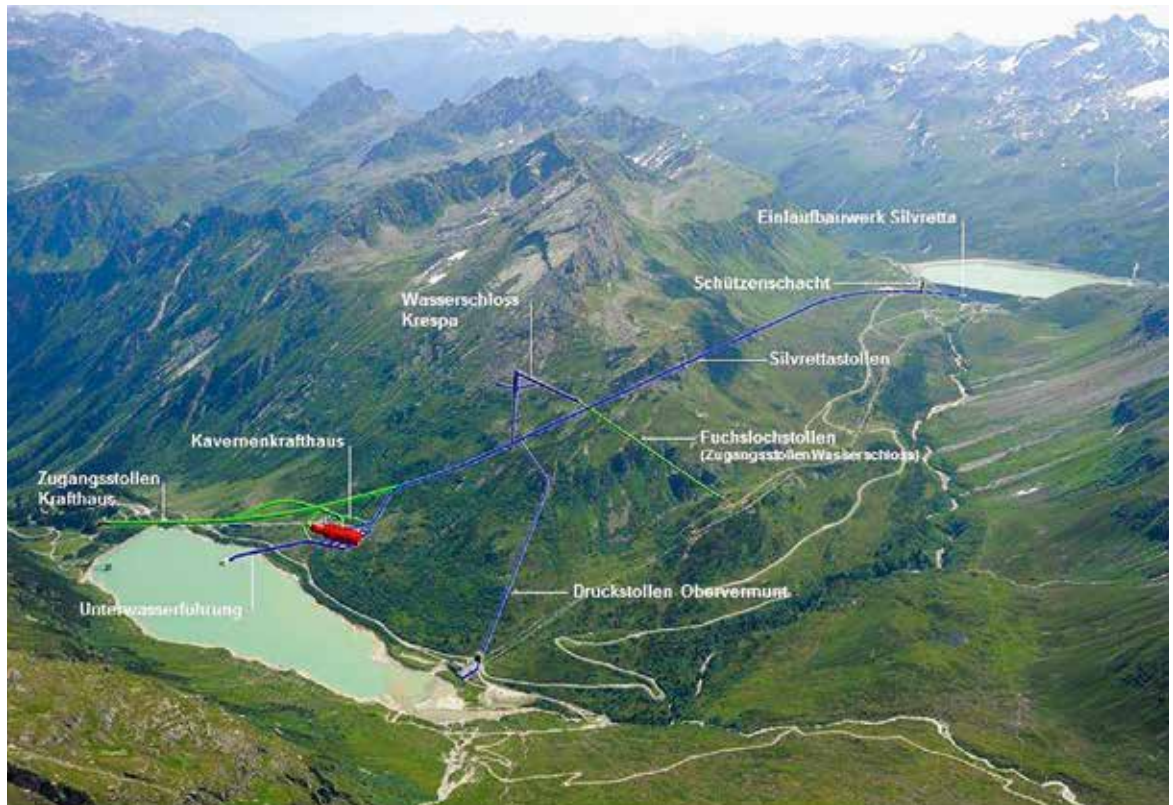
Anlagenübersicht Obervermuntwerk II, © VIW AG
