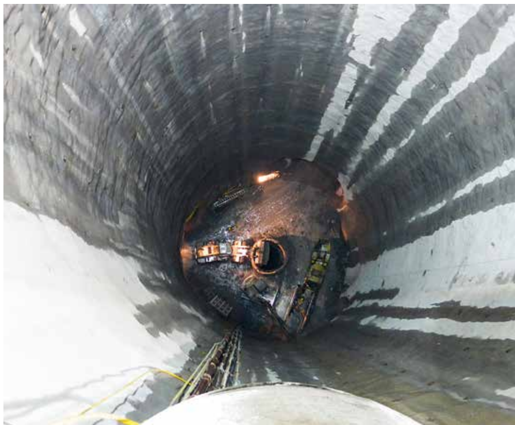
Blick in den Wasserschloss-Steigschacht auf Höhe der unteren Kammern
