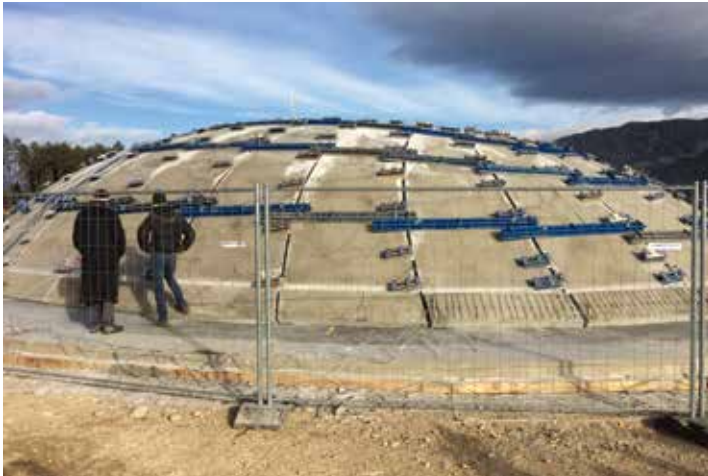
Die fertig „aufgeblasene“ Betonkuppel
