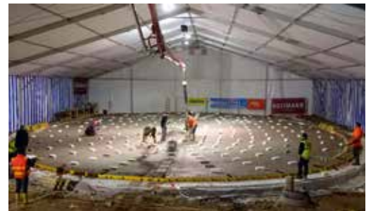
Betonage der ebenen Fläche
