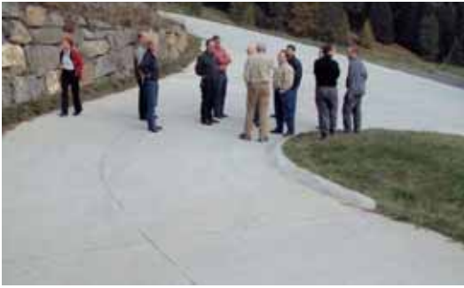
Abb. 7: Vollflächige Betonierung im Kreuzungsbereich
