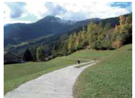
Abb. 14: Durchgehendes Betonieren im Kurvenbereich
