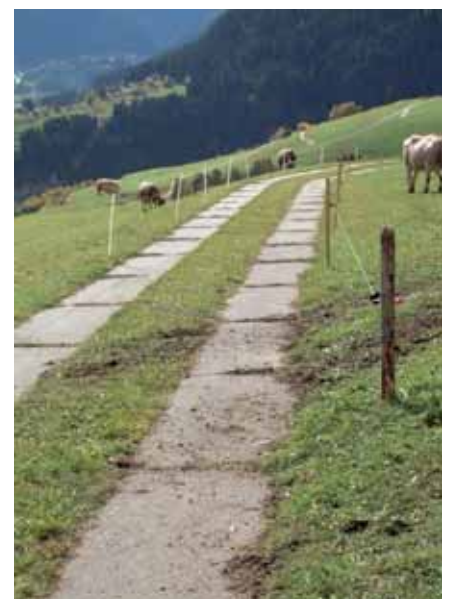
Abb. 3: Variante in Fertigteilbauweise
