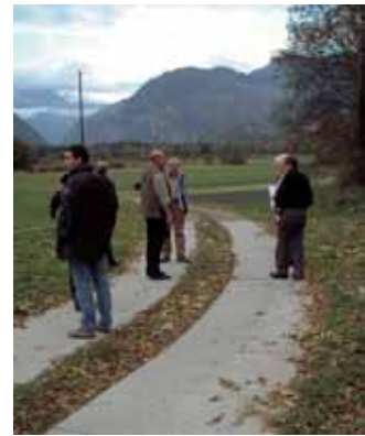
Abb. 13: Spurverbreiterung im Kurvenbereich
