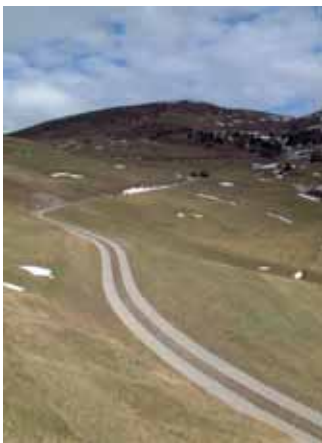
Abb. 10: Fertigteile im Almbereich
