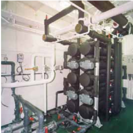
Bild 12: Mittelgroße Binäreismaschine (z. B. 8 Stück für den Autobahnbau mit 3.000 m 3 /d)
