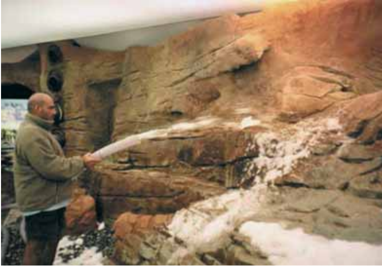
Bild 16: Verblasen von Binärschnee (pneumatische Förderung) in einem Pinguin-Gehege
