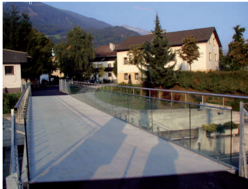
Bild 5.2 b: Fertige Brücke mit Glasgeländerkonstruktion
