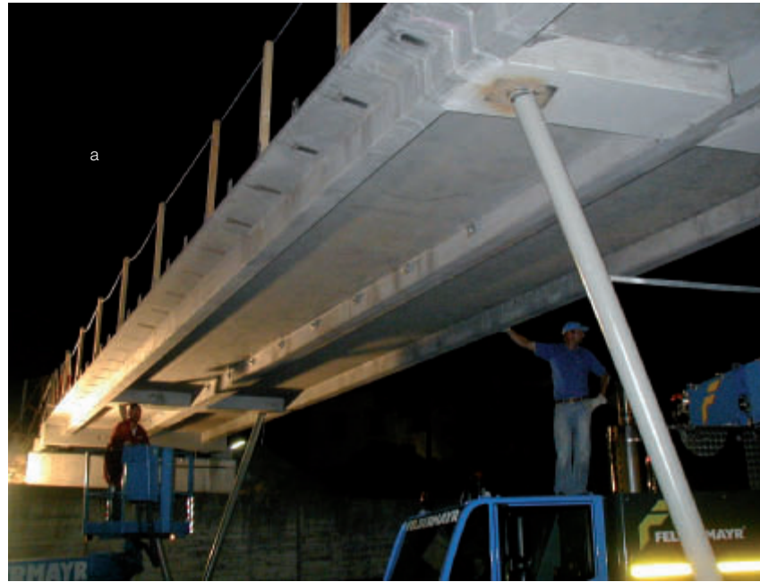
Bild 5.2 a: Montage der Brücke
