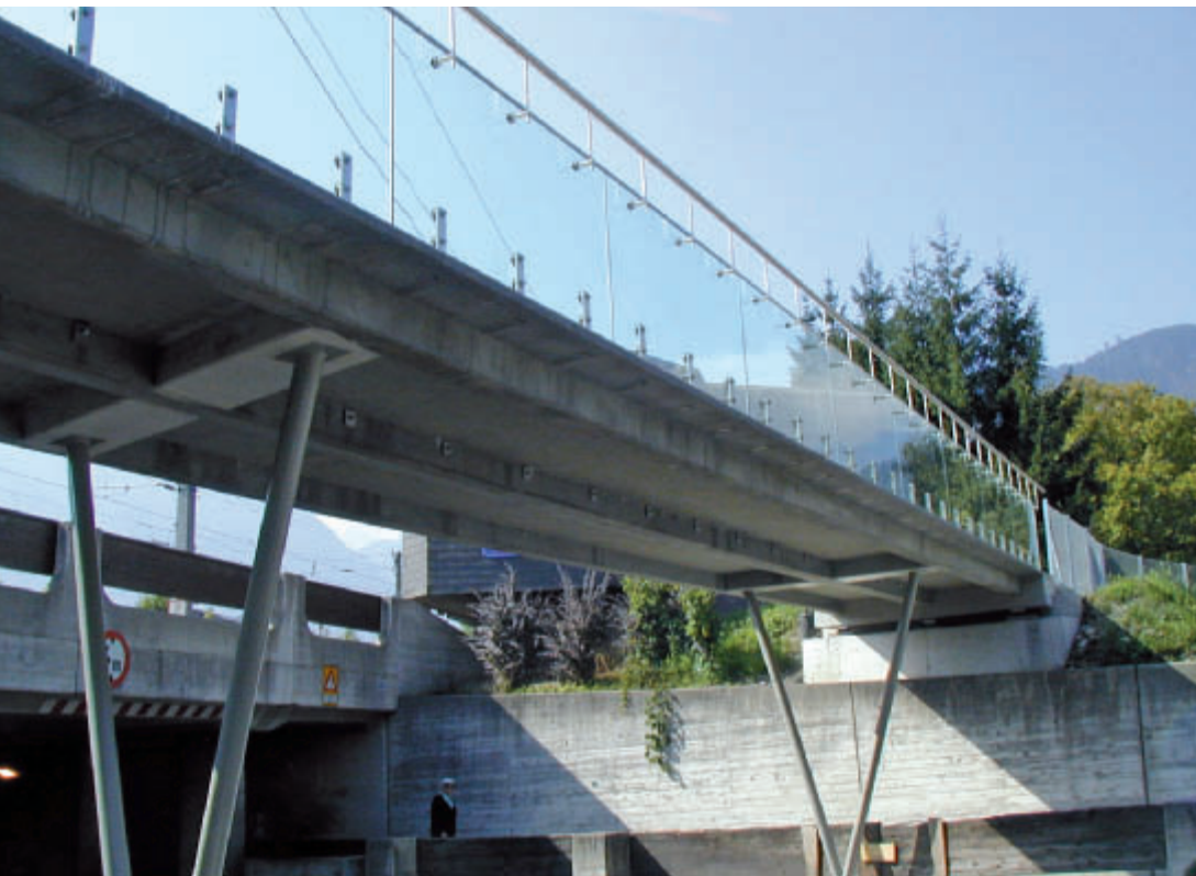
Bild 1.1: Ansicht der Fußgängerfertigteilbrücke Lienz
