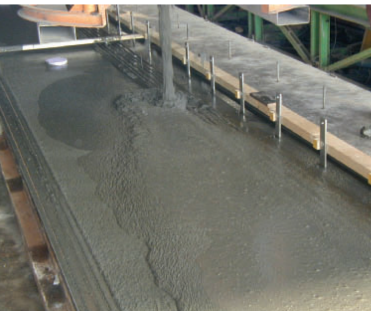
Bild 5.1 a: Betonage der Fertigteile
