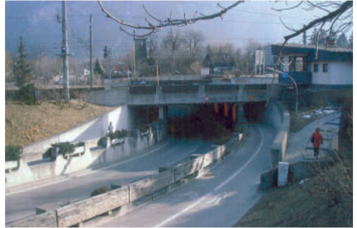
Bild 3.1: Ursprungssituation des Bestandes vor dem Bau der Brücke
