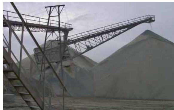
Abb. 4: Deponierung bei Nassaufbereitung
