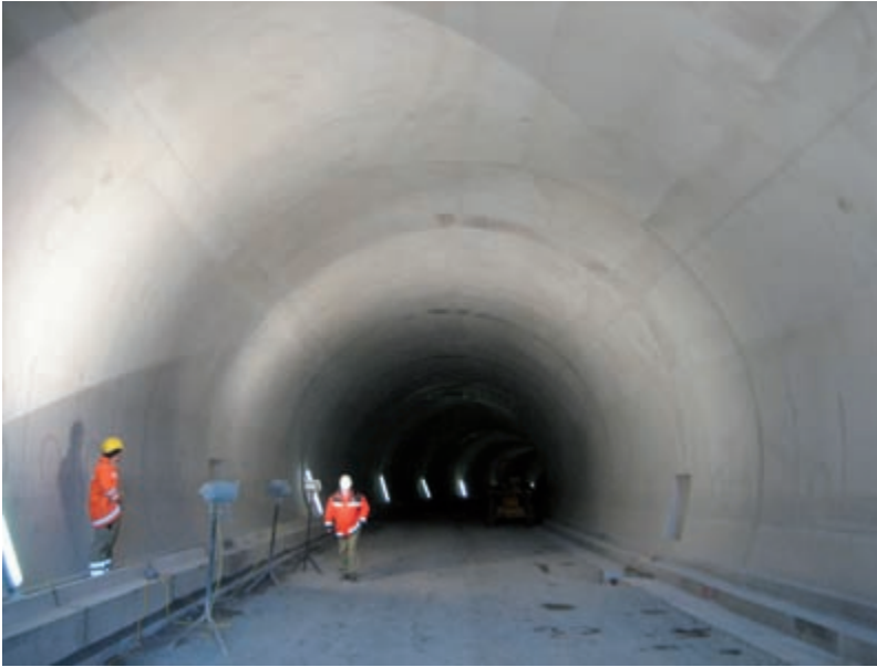
Pilotversuch im Massenbergtunnel
