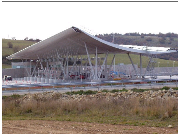
Fertiges Dach der Mautstation
