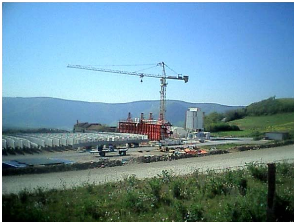
Feldfabrik für die Herstellung der Fertigteile
