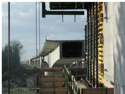
wurden die Zuschläge und das Zugabewasser so weit abgekühlt, dass die Frischbetontemperatur unabhängig von der Witterung in etwa zwischen 21 und 23 °C betrug. Diese Temperatur hat sich in Bezug auf die Dauer der Verarbeitbarkeit sowie der Wirkung der chemischen Zusatzmittel als am Günstigsten erwiesen.
