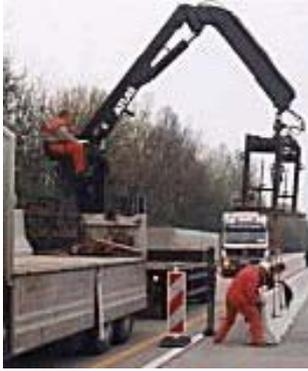
Aluminium Leitschienen waren in der Vergangenheit schon öfters Auslöser für schwere Unfälle auf Österreichs Straßen. Da die ALU Leitschienen mit zunehmendem Alter immer spröder werden, brechen diese bei starkem Aufprall und können in die Fahrzeuge eindringen.
