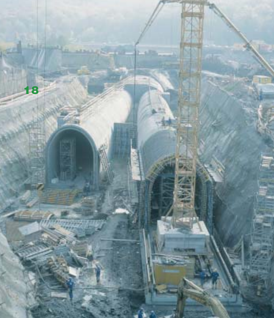
Bild 4 Zulaufstrecke Lainzer Tunnel – 20 m unter Grundwasserspiegel
