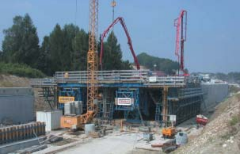
Bild 9 Unterflurtrasse Steinhaus – 24 m – Betonierabschnitt
