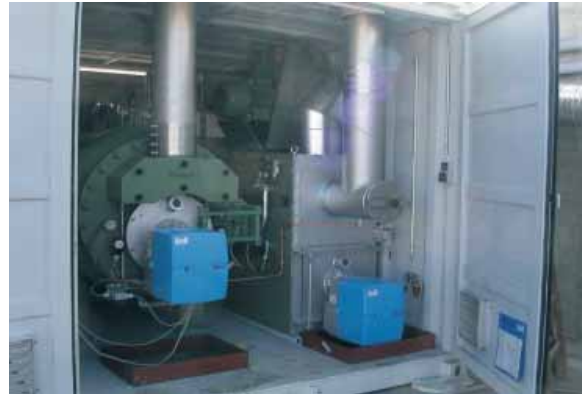
Bild 11: Kombinierte Warmwasser und Warmluftheizung in mobiler und stationärer Ausführung
