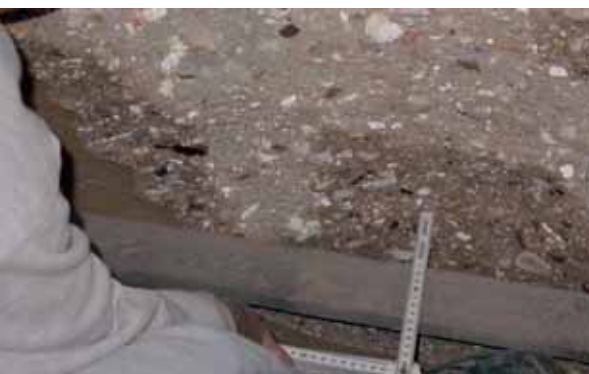
Bild 7: Kalotte mit Beton MV 1,5; Abplatzungen während des Brandversuches (braun verfärbte Oberfläche) und nach dem Abkühlen abgefallener Beton (helle Oberfläche)
