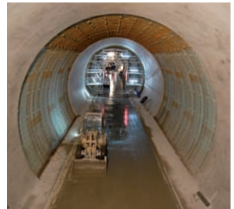
Bild 5: Auf Lücke betonierete Brandschutzschale
