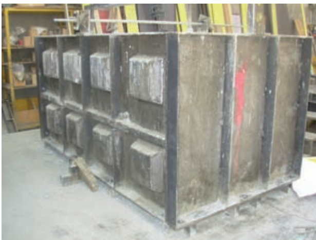
Stahlschalung für den Betonblock
