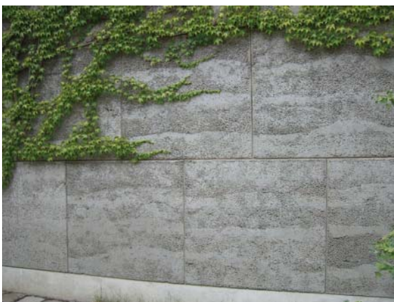
Abb. 1: Haufwerksporige Leichtbeton Struktur als architektonisches Motiv (Kirche der Pfarre Lainz-Speising/Wien)
