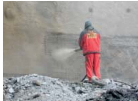
Bild 4: Erste Baustellenerfahrung an einer Baugrube
