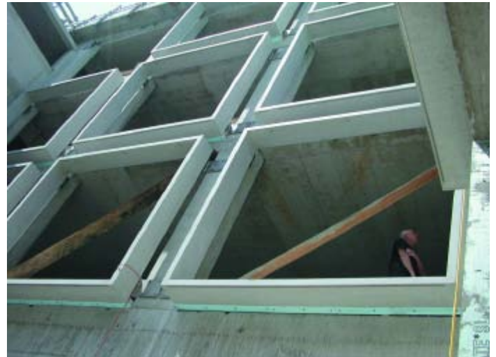
Abb. 5: Werksgefertigte Fassadenelemente aus selbstnivellierendem Hochleistungsbeton beim „Stadtforum Innsbruck“
