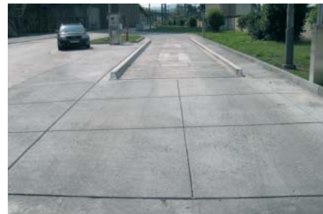
Bild 14: Fertige Whitetopping-Versuchsfläche, FP ZW-Wetzlar
