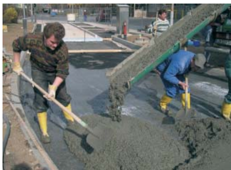
Bild 11: TCW/UTW-Einbau, FP ZW Wetzlar
