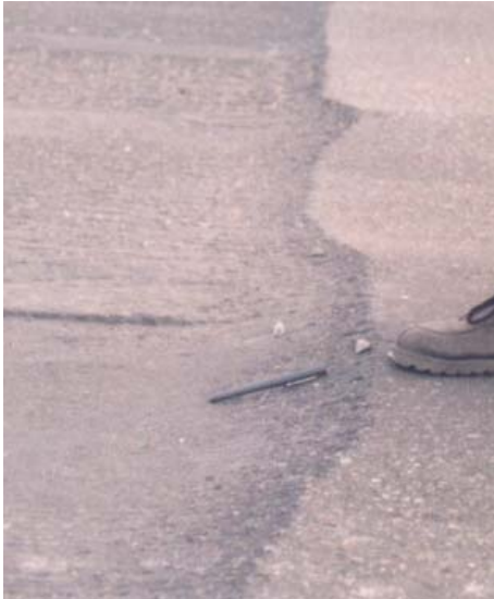
Bild 3: Spurrinne/gefräster Asphalt
