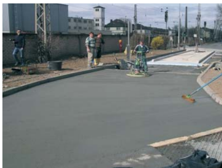
Bild 12: TCW/UTW-Einbau, FP ZW Wetzlar
