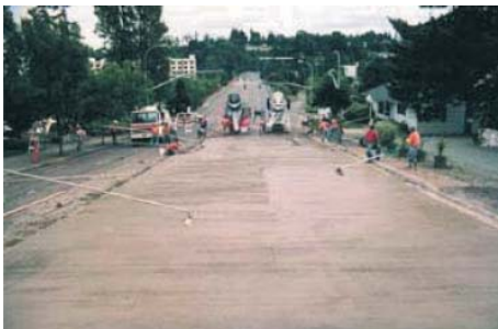
Bild 4: UTW-Einbau (USA)
