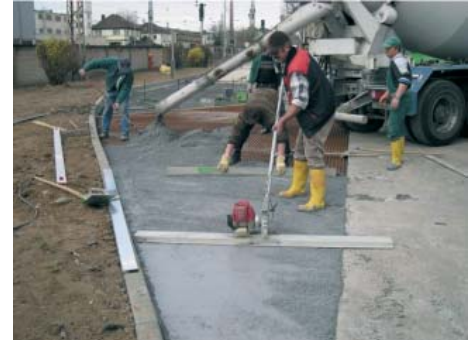
Bild 8: Einbau „Ferroplan“, FP Zementwerk Wetzlar
