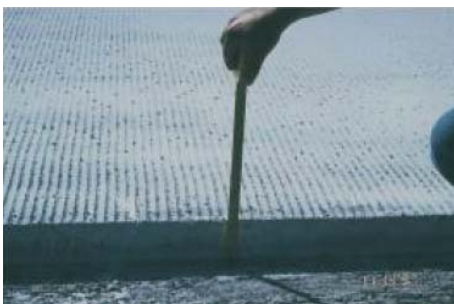
Bild 6: Fertiger UTW-Belag mit Kammtextur, quer (USA)
