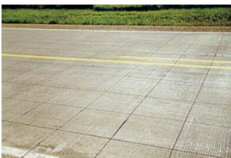
Bild 5: Fertige UTW-Fahrbahn (USA)
