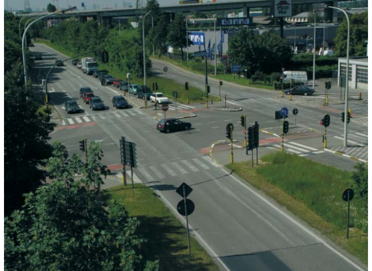
Bild 7: Whitetopping-sanierte Kreuzung, Belgien
