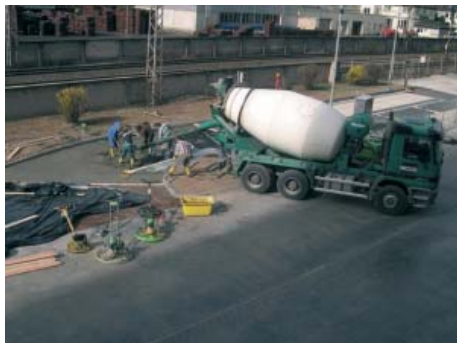
Bild 10: TCW/UTW-Einbau, FP ZW Wetzlar
