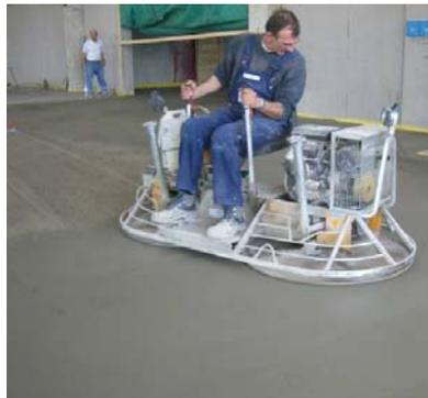
Abb. 2 Flügelglätten der Betonoberflächen nach Aufbringen der HKE
